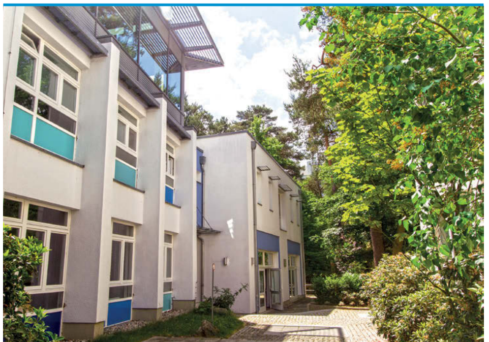
► Seitenansicht der Wannsee-Schule
